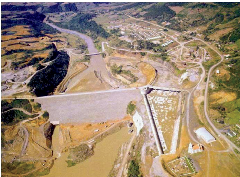
Figura 2: Início da construção da Barragem Norte
