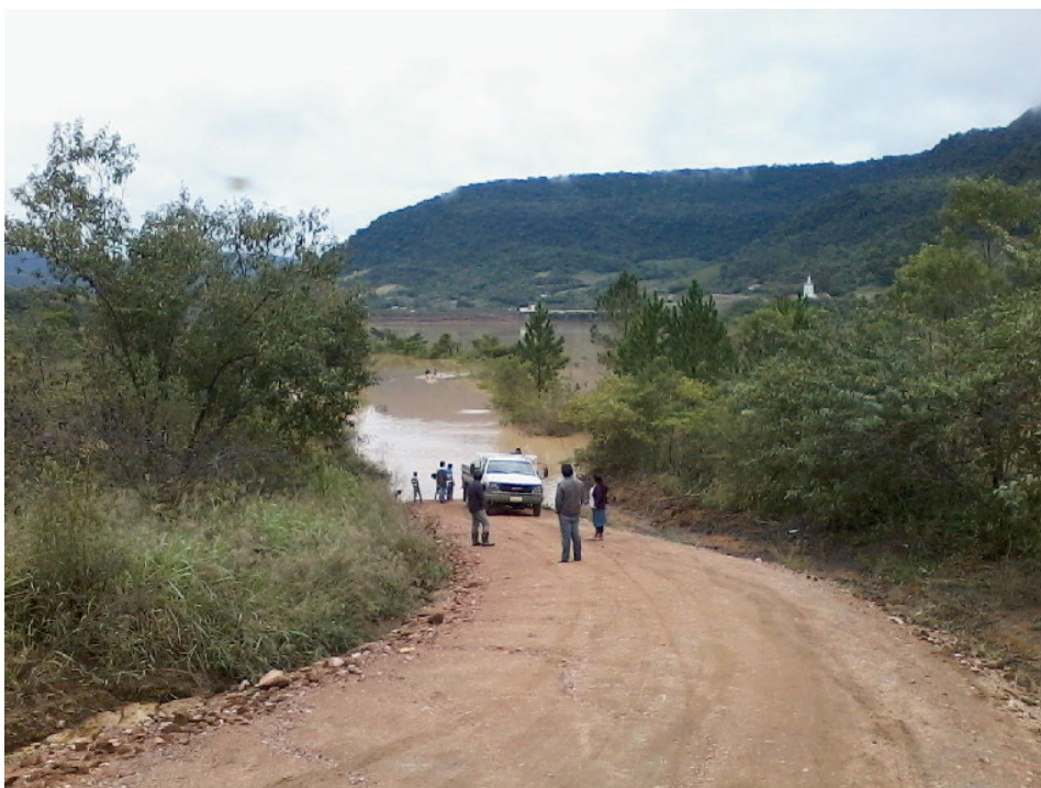
Figura 5: Estradas de acesso as aldeias de baixo da água com a enchente
